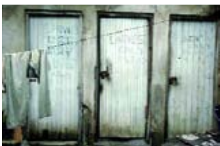
Ci-dessus Toilettes dans le quartier de Ilala, Dar es Salaam, Tanzanie.
